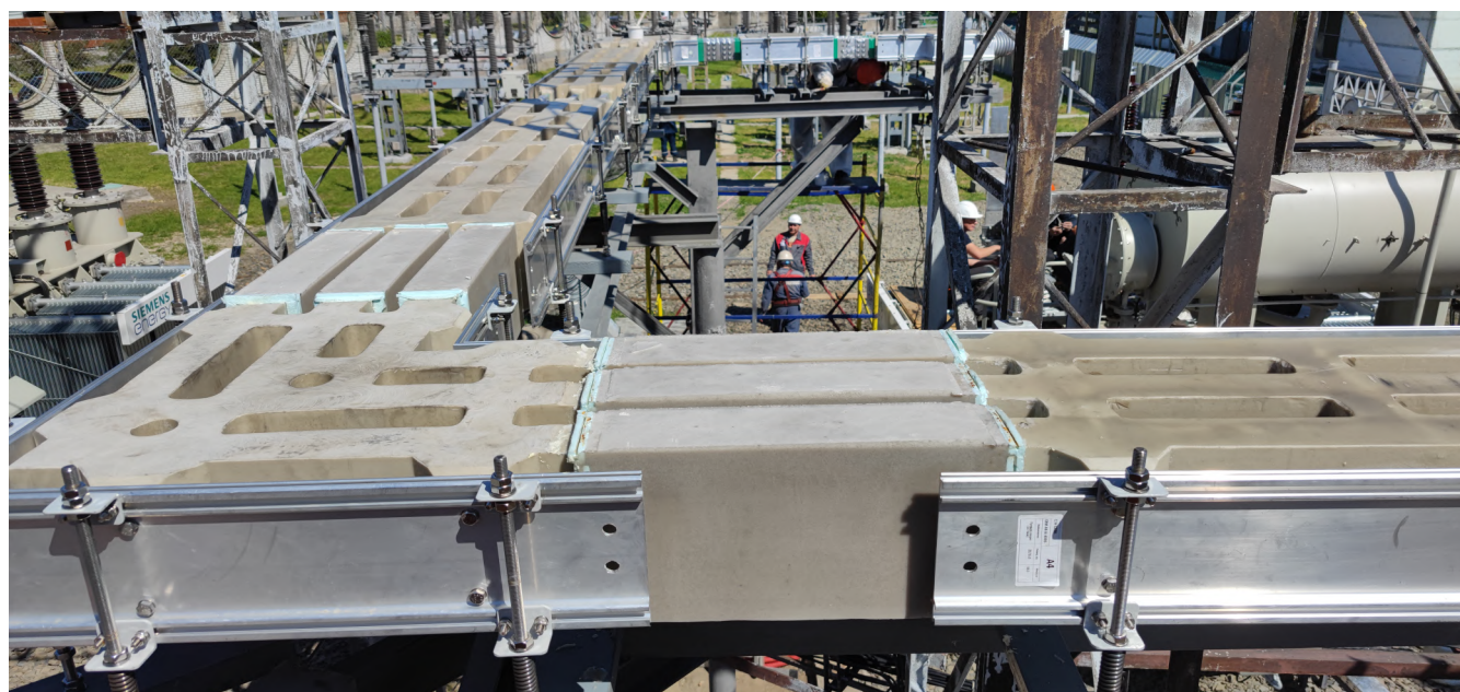
Пример. Процесс демонтажа токопровода на объекте
